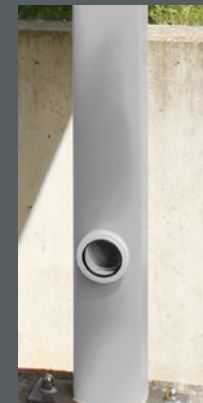
Entwässerung durch Stütze
