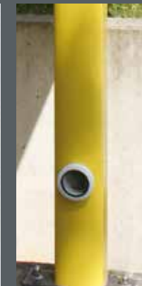
Entwässerung durch Stütze
