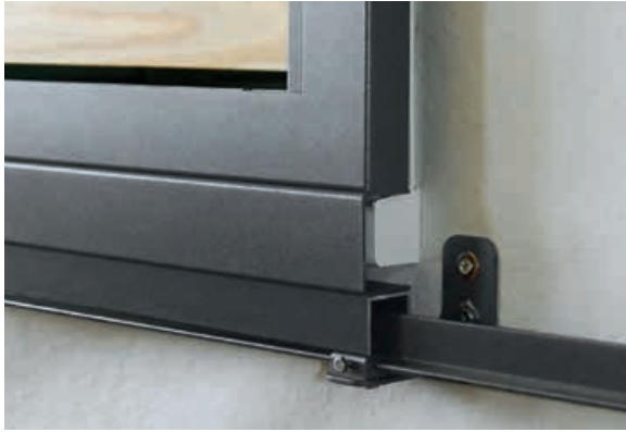
Untere Führung abgedeckt | Lower guide covered
